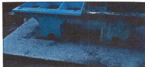
Foto 12: Sustitución de piso de torta de concreto
