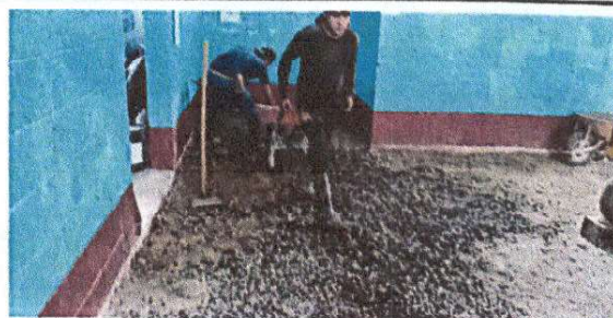
Foto 6: Reparación de piso de torta de concreto
