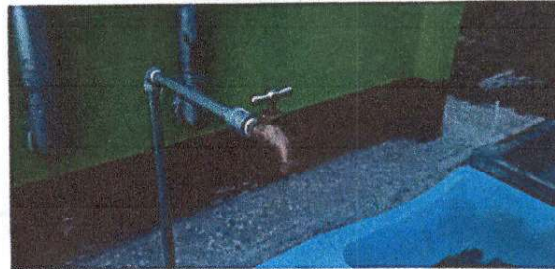
Foto 10: Sustitución de llave de chorro.
